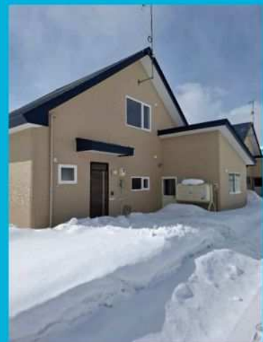
農業研修生用住宅（外観）
